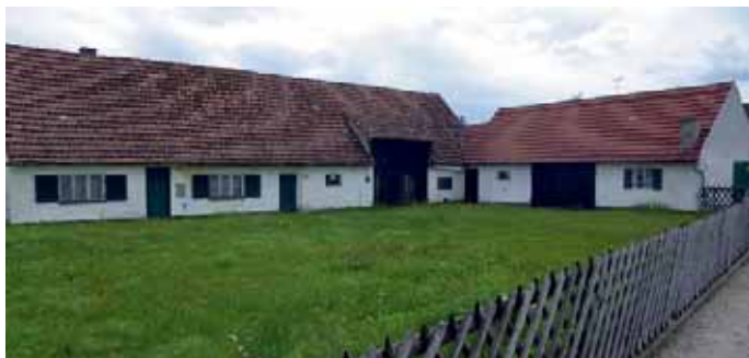
Die ersten Häuser bei der Besiedelung des Donaumoses
