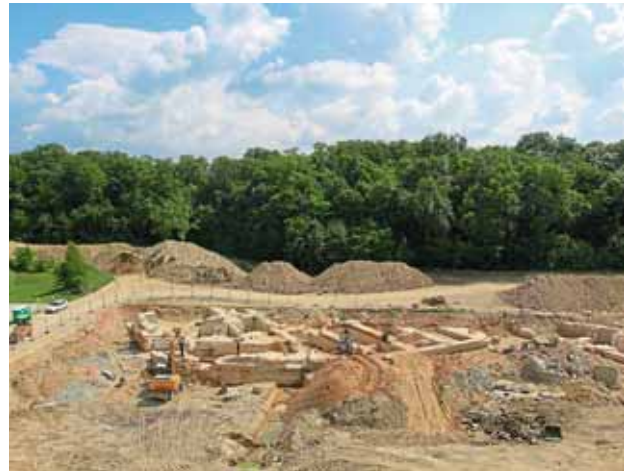
Festungsfundamente unter dem Grüngürtel von Ingolstadt
