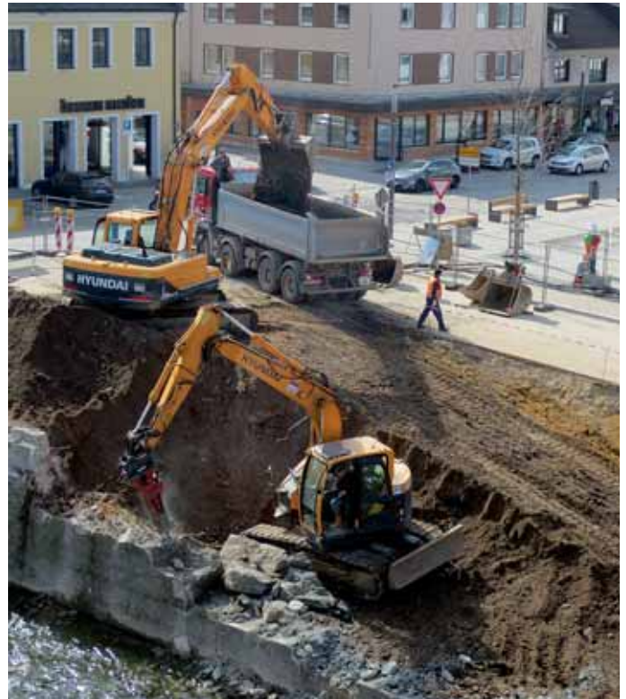
Grubenaushub und Abriss der alten Ufermauer. Markt Manching (StH)
