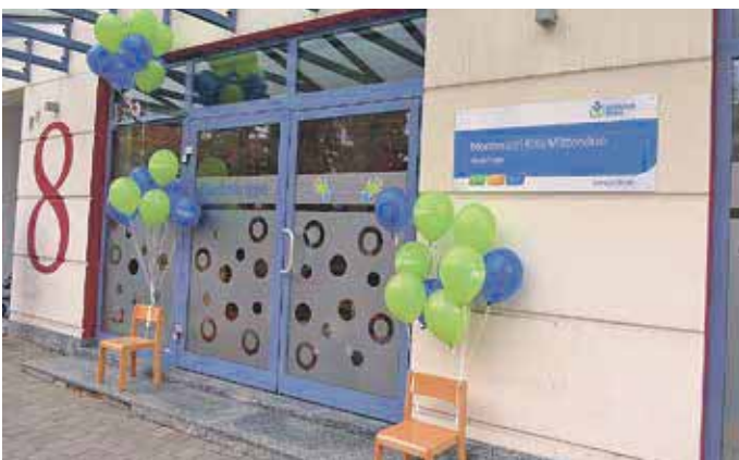
Außenansicht der neuen Montessori Kinderkrippe Mittendrin in Manching.
