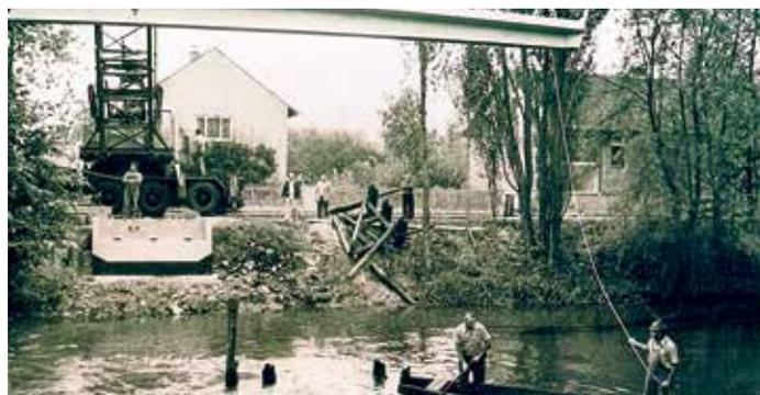
**1975 ersetzte eine aus Spannbeton gefertigte Brücke die alte Holzbrücke über die Paar.**
