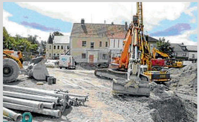
Vorbereitungsarbeiten für den Erdaushub beim Neubau der Gemeindebücherei
