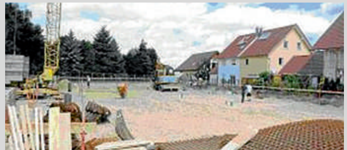
Neubau der Kindertagesstätte im Altenfeld; Erdarbeiten
