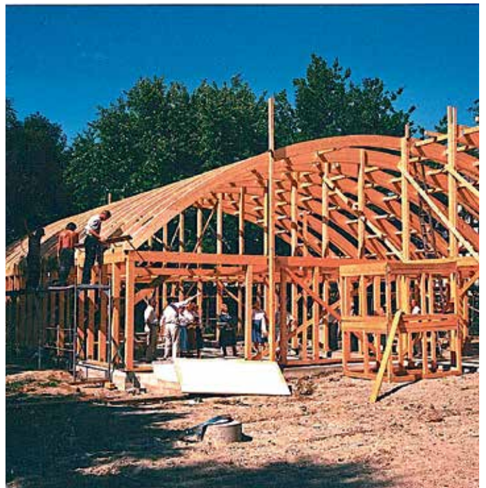
Bald ist der evangelische Kindergarten der in Holzbauweise errichtet wurde Geschichte und ist nur noch in Fotografien erhalten.
