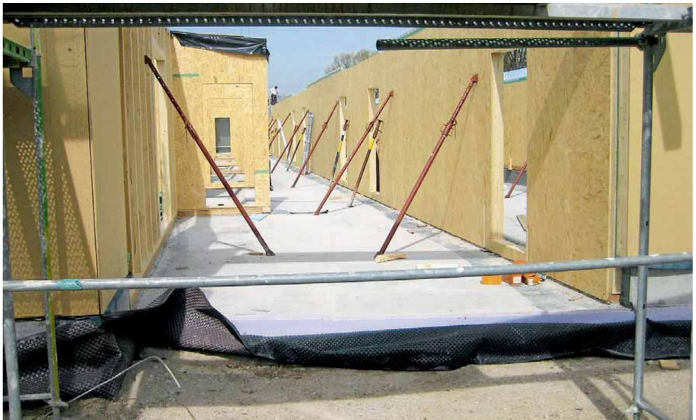
Die Holzständerkonstruktion mit den Wänden steht bereits. Als nächster Arbeitsschritt folgt dann die Aufbringung des Daches. Vom Grundprinzip entsteht das Gebäude für die Kinderkrippe analog der KiTa im Altenfeld. Über den weiteren Baufortschritt werden wir berichten.
