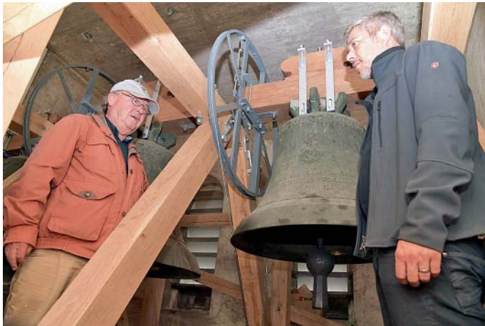
Kirchenpfleger Ludwig Gampfl und ein Bauauftragter vom Architektenbüro Springer begutachten den neuen Glockenstuhl der Kirche in Oberstimm.
